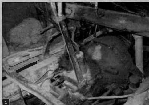
1 L'accessibilité est un avantage indéniable des "avant-guerre" et des voitures à châssis séparé en général ; il suffit de retirer le tapis de sol puis de démonter les planchers pour accéder à la boîte de vitesses. Par commodité et sécurité, les batteries ont été retirées.
