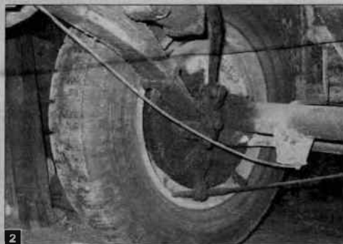
2 Sur ce genre d'auto, le pont doit être reculé pour pouvoir dégager la boîte. Il faut donc étayer la caisse, sous les longerons, en avant du pont, juste à la limite de pendre le pont au bout des lames mais sans décoller les roues. On se contente d'abord de décrocher la liaison des bras d'amortisseurs.
